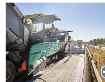
→ Rabotage et décapage de la chaussée existante sur 8 centimètres.
